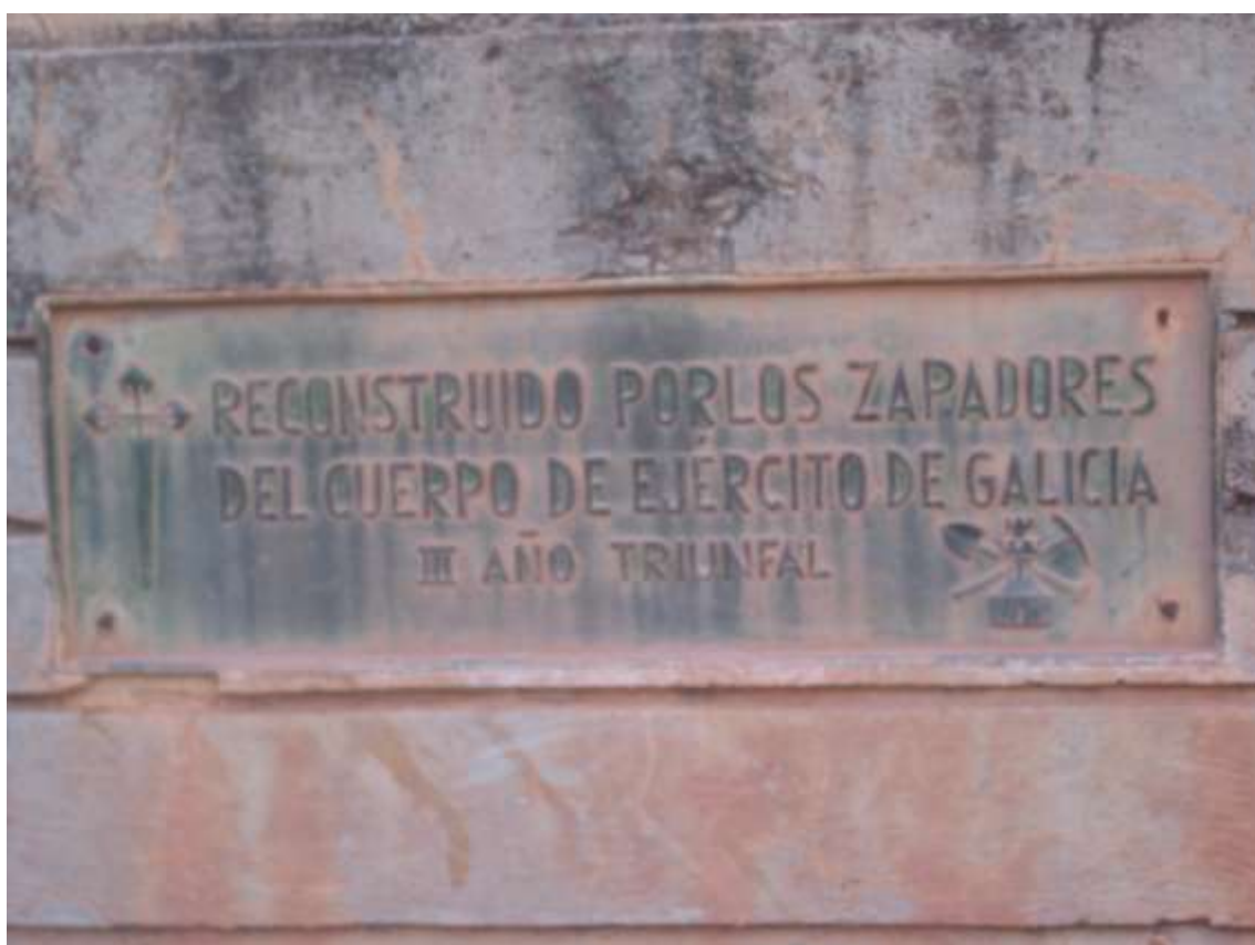
detall entrada dreta i esquerra del pont
