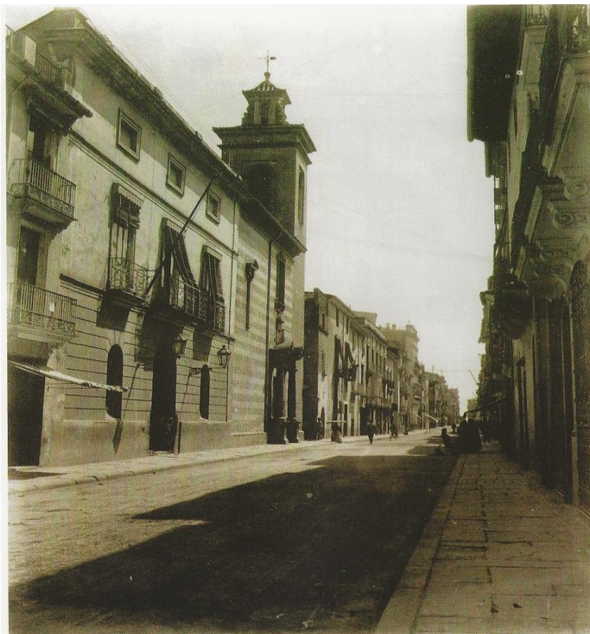
Sede del Gobierno Civil de Castellón en la calle Mayor, contíguo a la Iglesia de San Agustín
