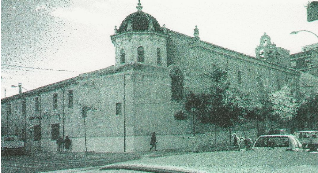
Hospital de Villarreal
